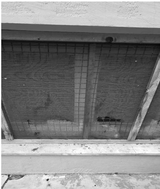
Εικόνα 4 Λεπτομέρεια πλέγματος προστασίας κουφώματος
